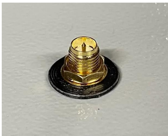
Figura 9: Cable de extensión de antenna instalado
